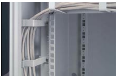
Rys. 6. Wieszak do mocowania wiązek przewodów
